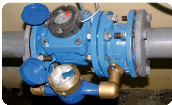
Общедомовой водосчетчик
