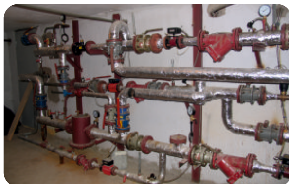
Тепловые пункты, прошедшие реконструкцию
