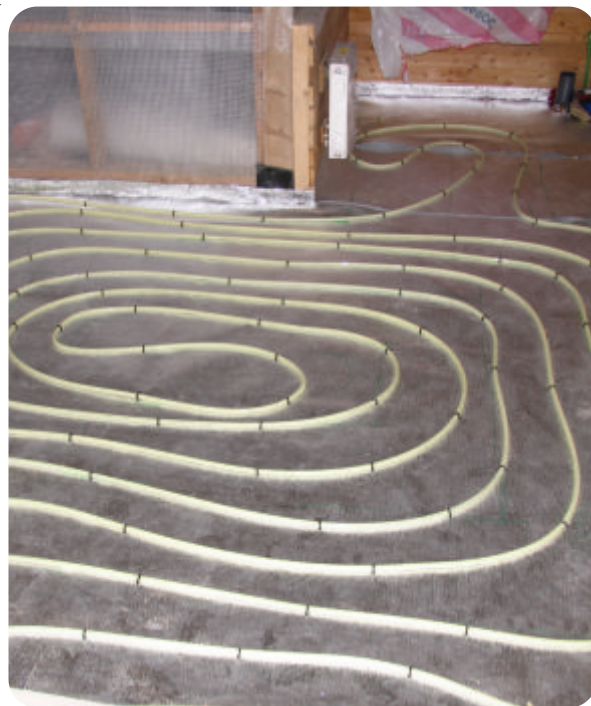
Монтаж теплых полов
