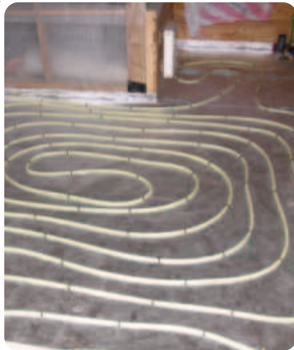
Монтаж теплых полов
