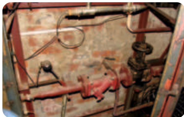
Нереконструированные тепловые пункты
